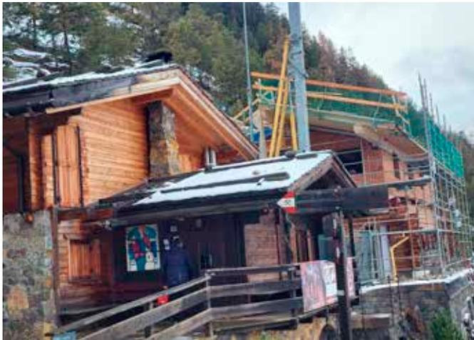
Vorne die bestehende „Knappenhütte“; dahinter wird auf dem bestehenden Unterbau (Umkleideräume, WC und Lager) ein zweigeschossiges Gebäude errichtet.
